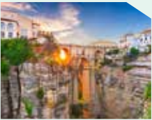
Puente Nuevo Ronda, Spain
